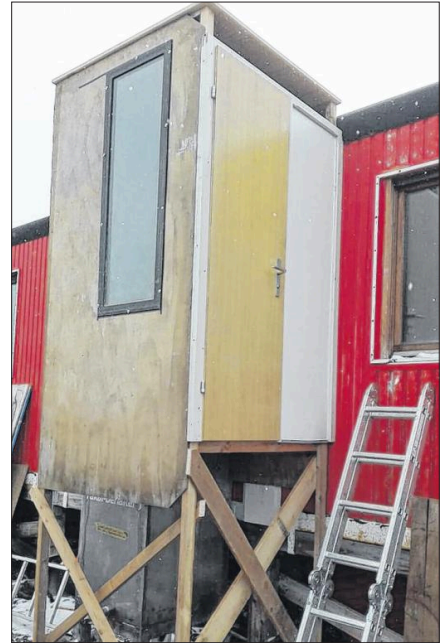
Plumpsko Marke Eigenbau. Zustieg per Leiter.
